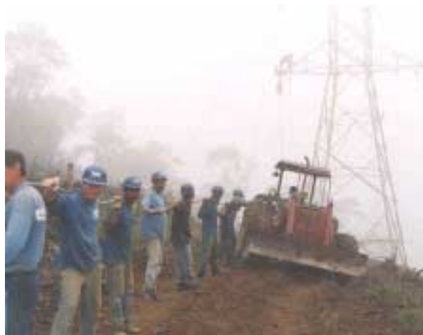
Lançamento de cabos
