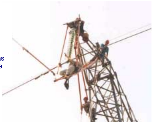
Reparo em isolador – linha de transmissão 230 Kv
