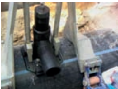
Figura 10.3 – Ligação e execução de ramais laterais após a intervenção
