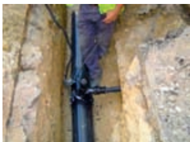
Figura 10.3 – Ligação e execução de ramais laterais após a intervenção
