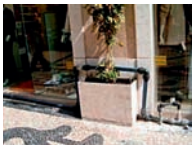
Figura 10.2 – Execução de ramais provisórios durante a intervenção
