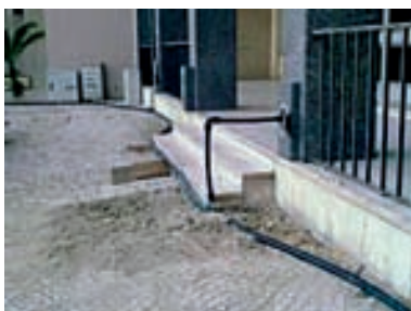
Figura 10.2 – Execução de ramais provisórios durante a intervenção
