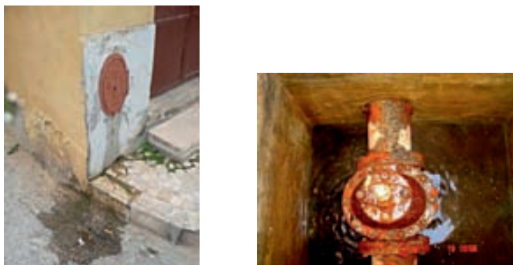
Figura 9.1 – Inspecção visual na zona circundante à conduta (à esquerda) e a válvula de seccionamento alojadas em caixa (à direita)
