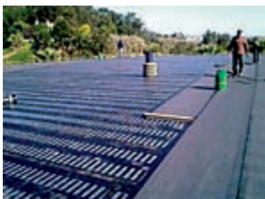
Figura 10.42 – Impermeabilização da cobertura do reservatório com tela impermeabilizante
