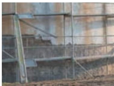
Figura 10.40 – Remoção do revestimento exterior e impermeabilização de reservatório (durante trabalhos de reparação)
