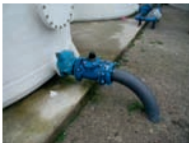
Figura 9.14 – Contador mecânico (também designado por medidor de caudal volumétrico) instalado à saída de reservatório
