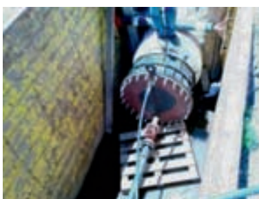
Figura 10.4 – Instalação de válvulas e acessórios após a intervenção
