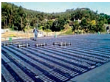
Figura 10.42 – Impermeabilização da cobertura do reservatório com tela impermeabilizante
