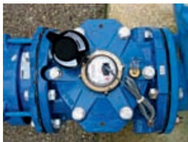
Figura 9.14 – Contador mecânico (também designado por medidor de caudal volumétrico) instalado à saída de reservatório
