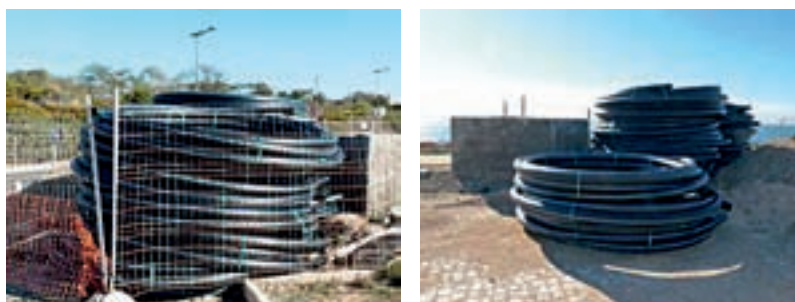
Figura 2.22 – Armazenamento de condutas de plástico sem protecção (necessária se for por período prolongado)
