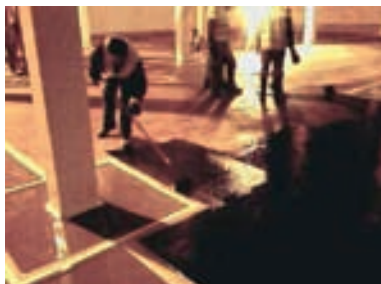
Figura 10.41 – Reparação da laje de fundo do reservatório
