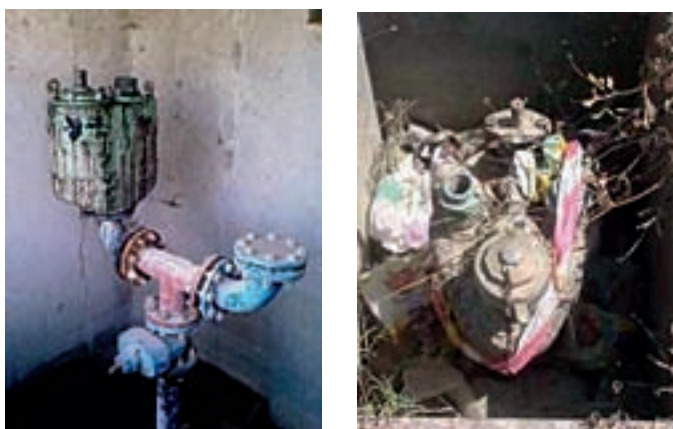
Figura 2.25 – Deficiente manutenção de ventosas
