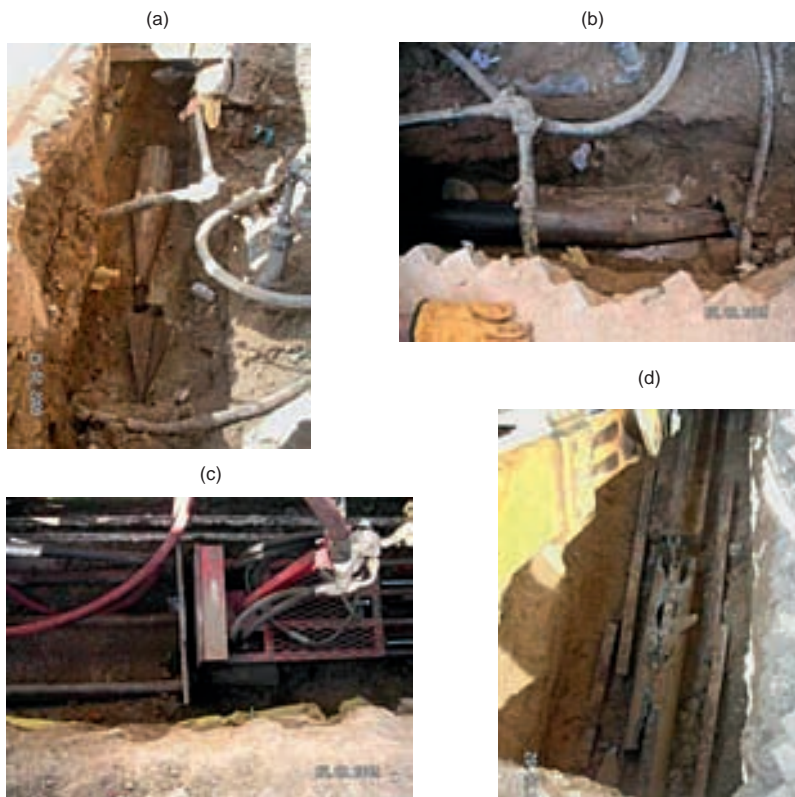
Figura 10.28 – Rebentamento da conduta existente: (a) cabeça cônica; (b) inserção de conduta de polietileno; (c) equipamento pneumático; (d) conduta destruída.
