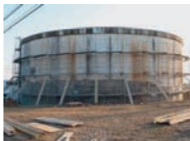
Figura 10.40 – Remoção do revestimento exterior e impermeabilização de reservatório (durante trabalhos de reparação)
