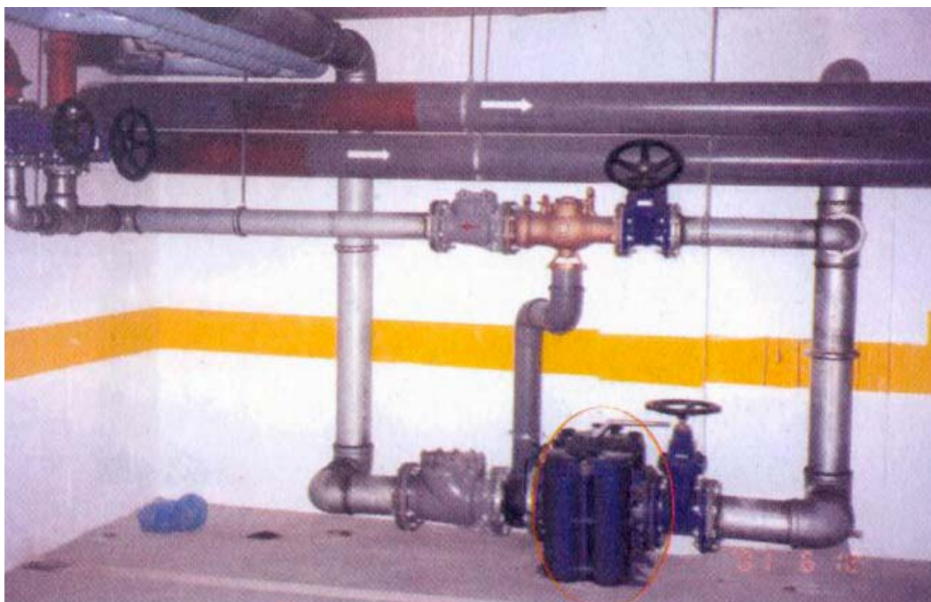
Fig. 11 – Instalação do filtro
