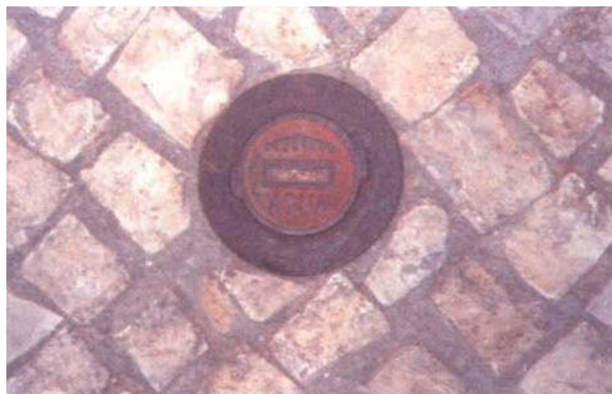
Fig. 16 – Tampa-válvula de seccionamento do abastecimento de água
