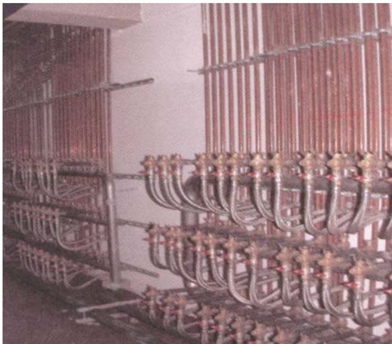
Fig. 10 – Contadores colocados em bateria
