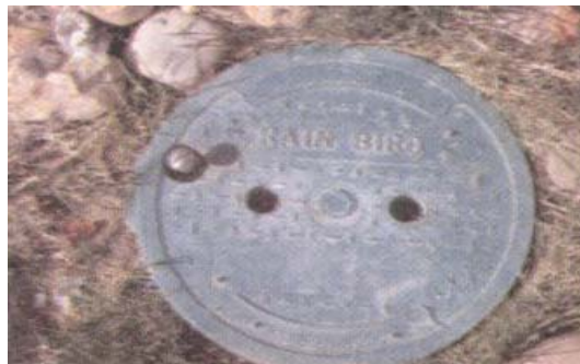
Fig. 17 – Caixa de protecção das válvulas da rede de rega
