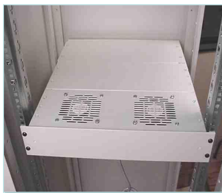
3.56 - Bastidor mural e sistema de ventilação
