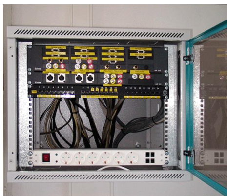
3.56 - Bastidor mural e sistema de ventilação
