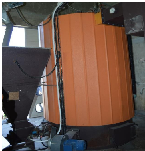
Figura 6 - Caldeira de biomassa para aquecimento de pavilhão de aves na zona da Ericeira | Fonte: RuralSmart
