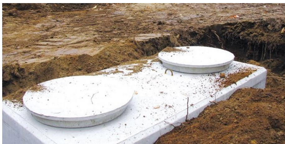
Figura 26 - Fossa para efluentes pecuários em fase de construção Fonte: https://www.villedemont-tremblant.qc.ca/en/citizens/my-property/septic-tank
