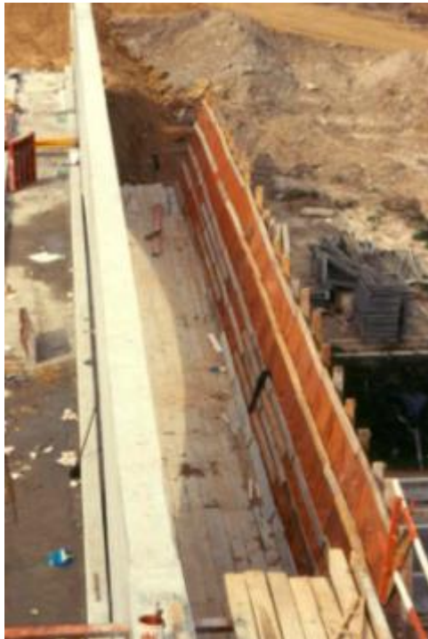
Plataforma de trabalho fixa na construção de um viaduto.
