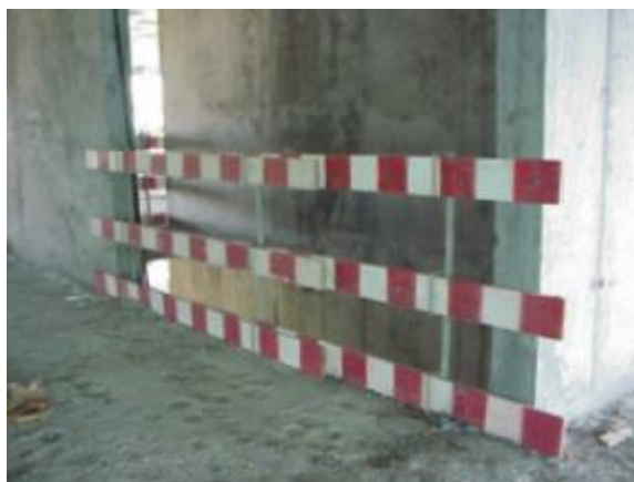
Utilização de guarda-corpos como proteção numa caixa de elevador.
