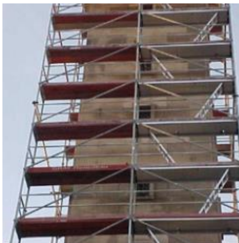
Acesso entre pisos por escadas com alçapão.
