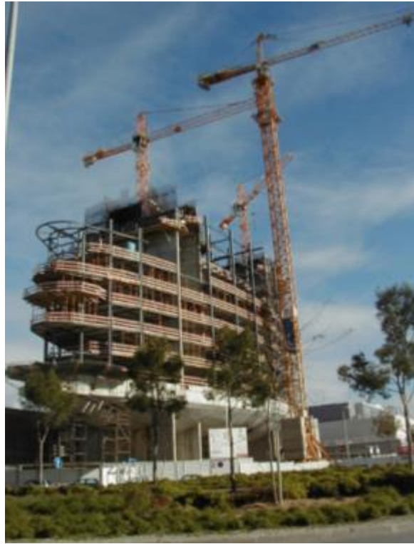
Utilização de guarda-corpos em vãos para o exterior.
