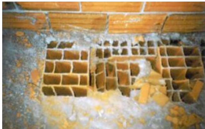
Abobadilhas utilizadas para colmatar uma abertura no pavimento.
