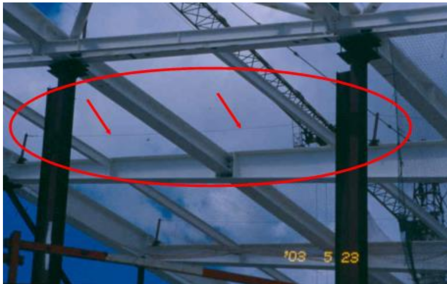
Linhas de vida instaladas na parte superior das vigas pertencentes à estrutura da cobertura.
