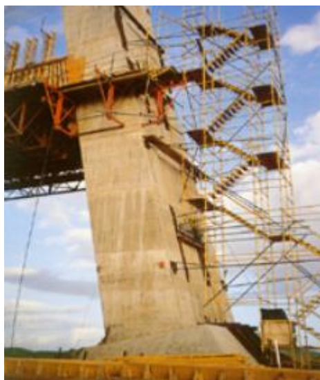
Escadas fixas metálicas.
