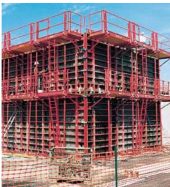
Painéis de cofragem com plataformas de trabalho acopladas.
