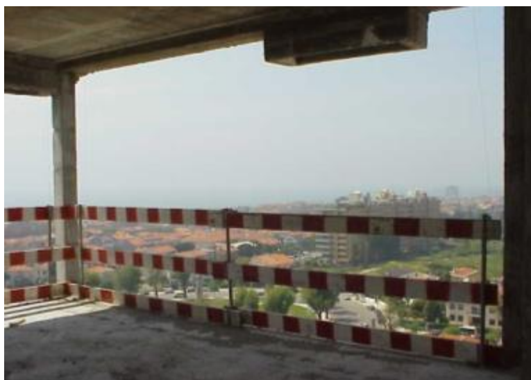
Exemplo de uma proteção contra quedas em altura.
