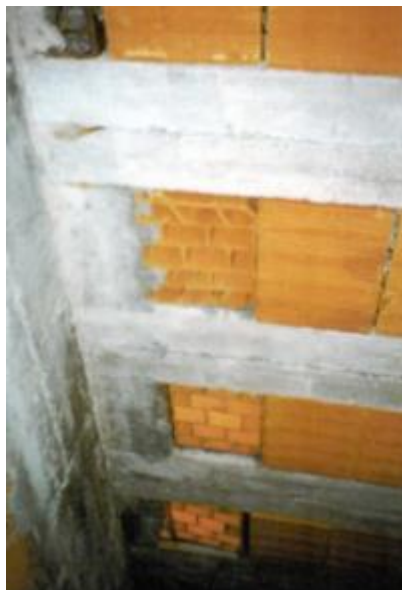
Abobadilhas utilizadas para colmatar uma abertura no pavimento.
