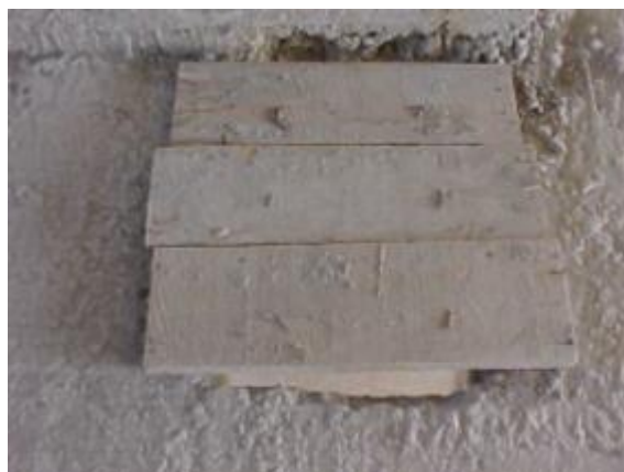
Tampa numa abertura no pavimento.
