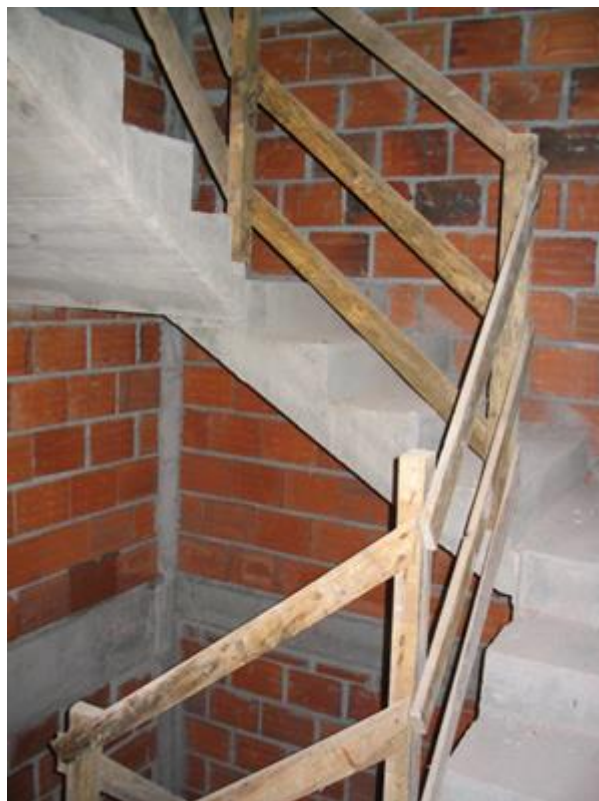
Utilização de guarda-corpos como proteção numa caixa de escadas.
