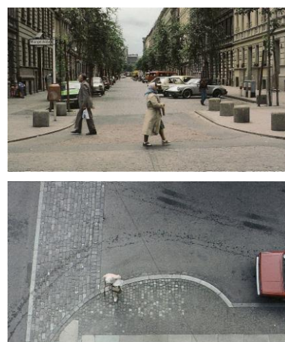
Figure 4 – Full curb extension parciais e totais utilizadas para diminuir as distâncias de atravessamento e melhorar a visibilidade quer para os peões quer para os condutores. Fonte: Calmar el trafico, 2008)
