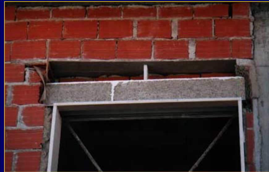
Correcção térmica na caixa de estore
