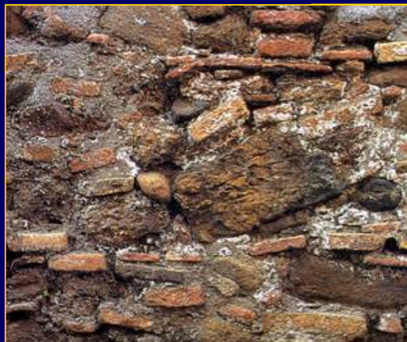
Reconstrução de alvenaria ordinária
